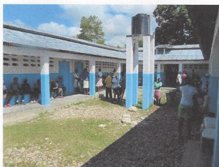
Cour intérieure sur laquelle donnent les salles de soins
