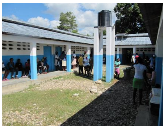
Der Innenhof mit angrenzenden Behandlungsräumen
